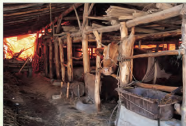
축사 chuồng gia súc 축사 지붕을 점검하거나 수리합니다. Kiểm tra hoặc sửa chữa mái chuồng gia súc.
